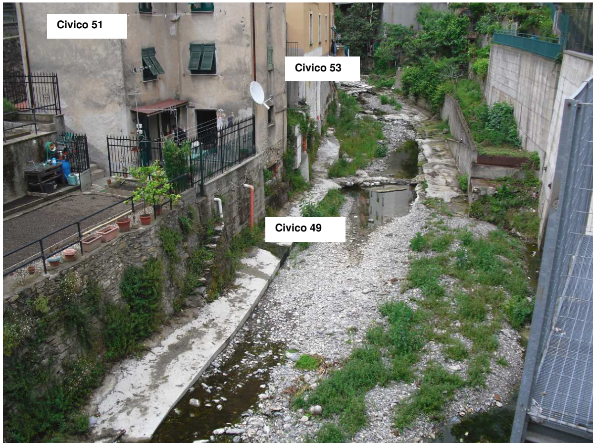
Foto 1: Vista dell'area di intervento dal ponte tra salita Ginestrato e via Pinetti.
