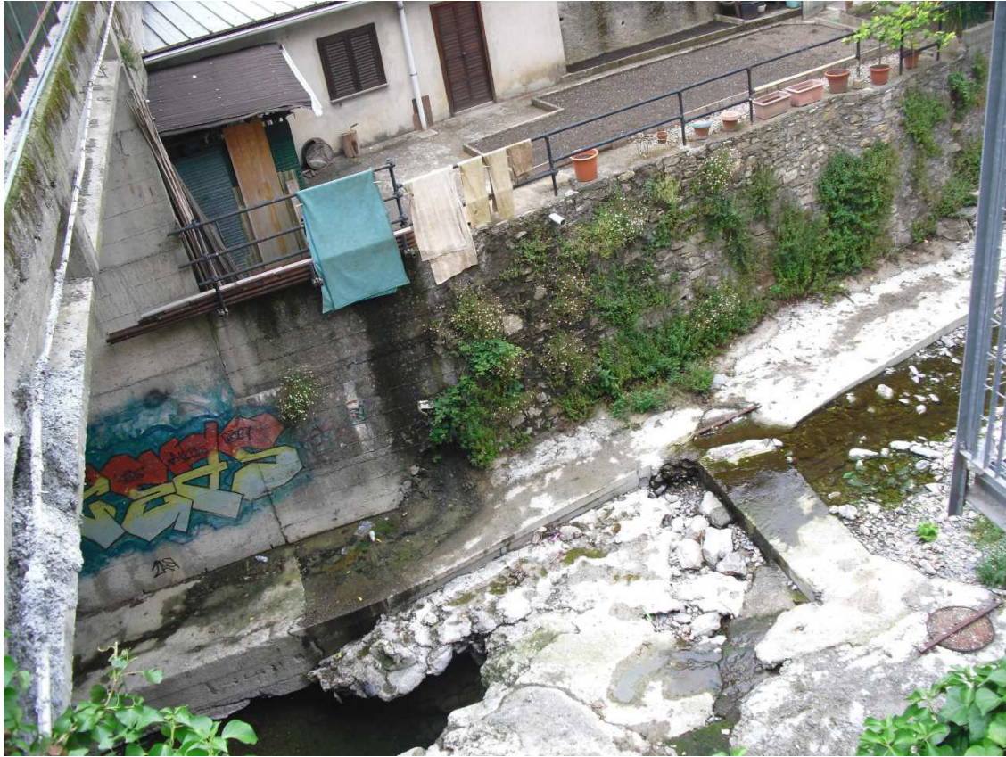
Foto 4: Imbocco della copertura del Torrente Fereggiano.
