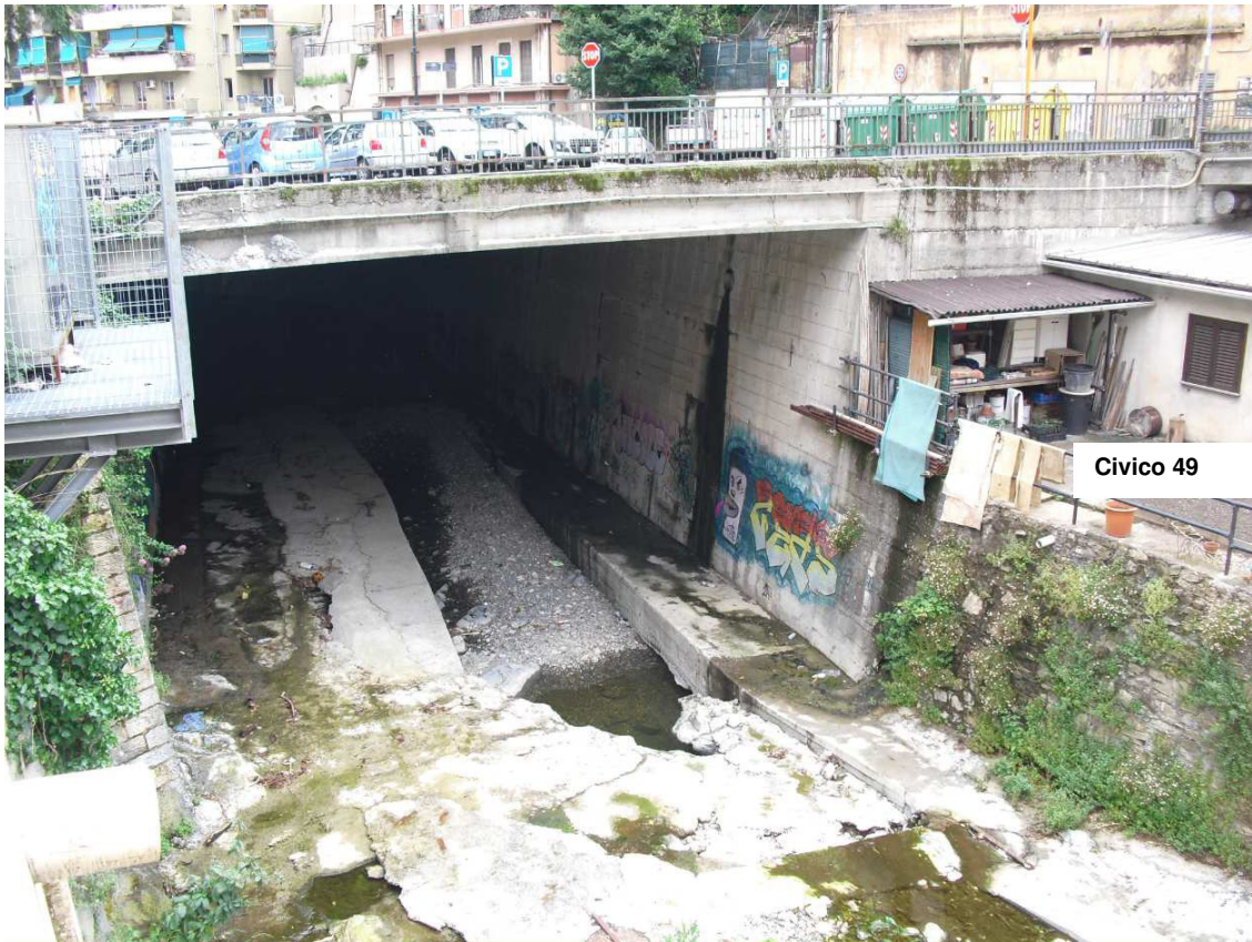
Foto 5: Imbocco della copertura del Torrente Fereggiano.
