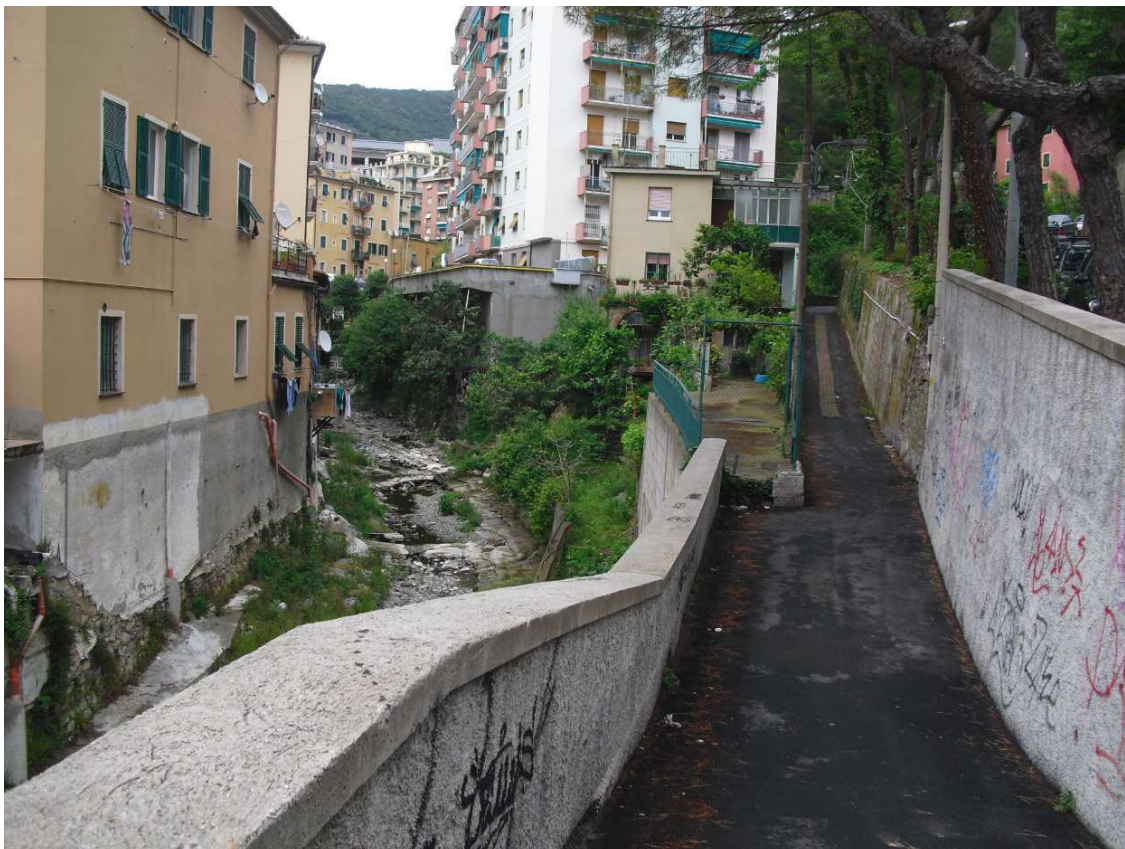
Foto 11: Percorso pedonale adiacente a Salita Ginestrato utile per collegare le aree operative in alveo con il cantiere su strada.
