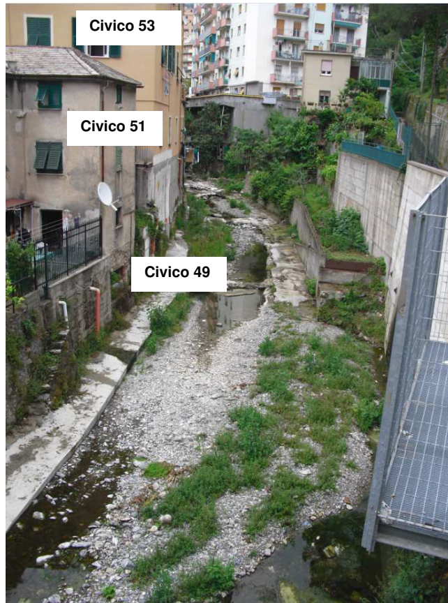
Foto 2: Vista dell'area di intervento dal ponte tra salita Ginestrato e via Pinetti.
